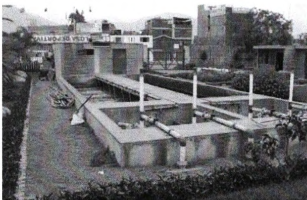
Figura N° 2.26: Planta de tratamiento por lodos activados de aireación extendida, construida con fines de riego de áreas verdes, en una berma central de la Av. Universitaria en Comas.
