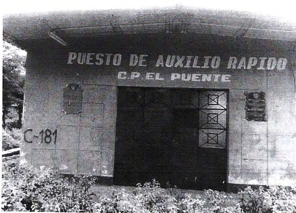
PUESTO DE AUXILIO RÁPIDO DEL C.P. EL PUENTE
