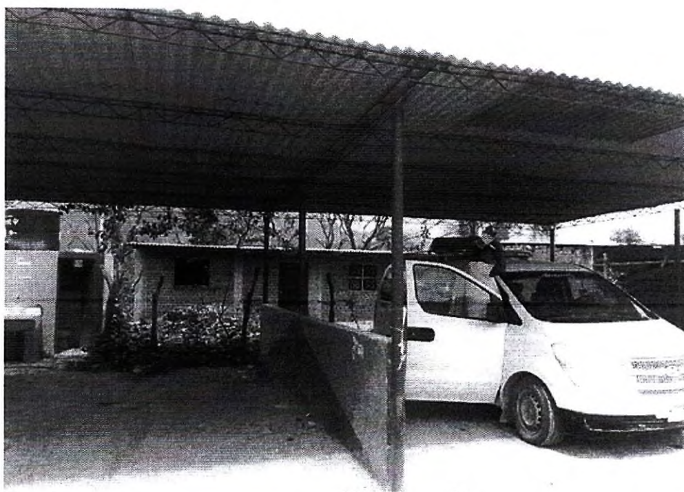
PARADERO CENTRO POBLADO EL PUENTE
