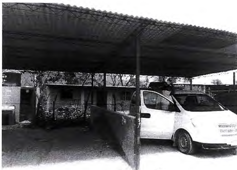
PARADERO CENTRO POBLADO EL PUENTE
