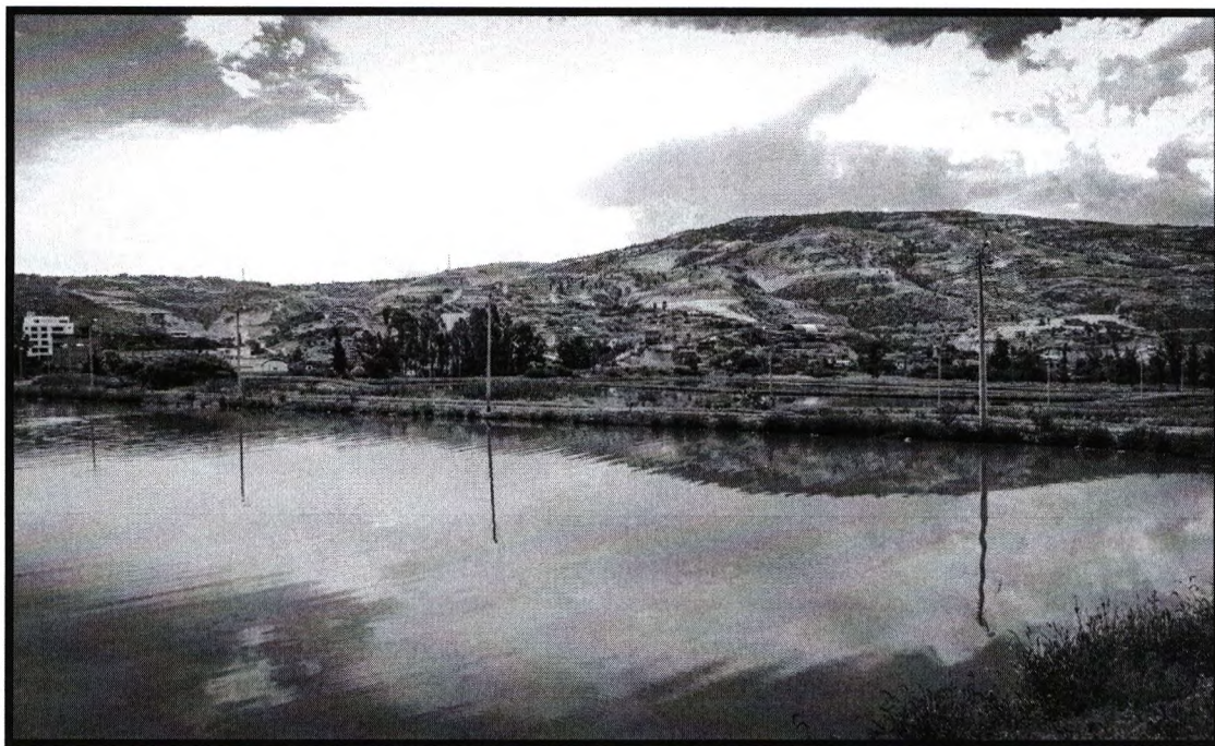
PTAR Totorá- Se encuentra en una operación sobredimensionada, lo cual está causando efectos ambientales - mayo 2023.
