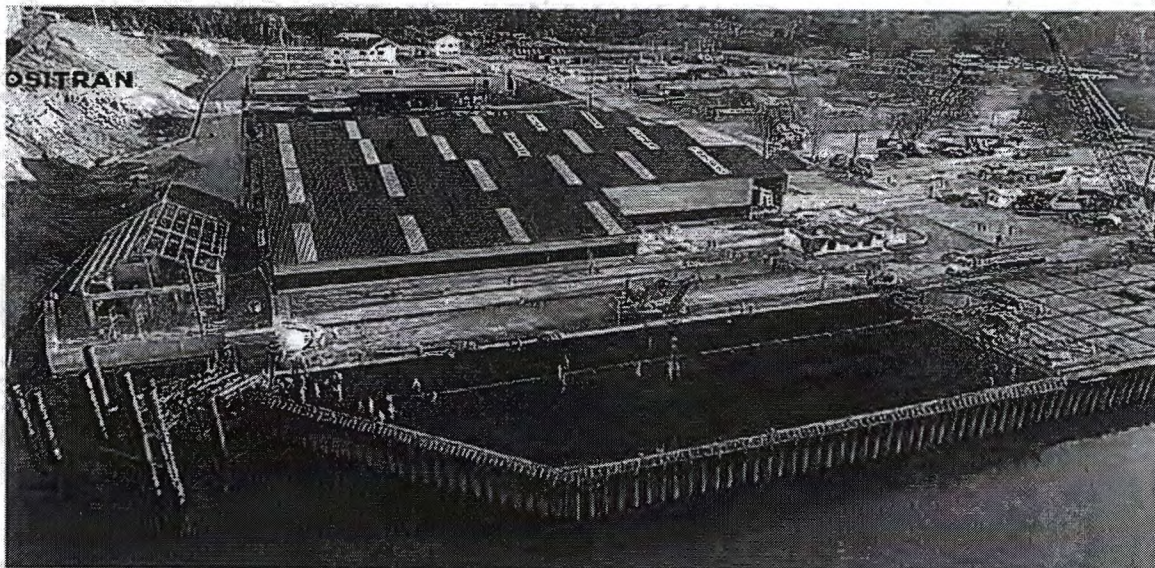
Foto 01: Nuevo Terminal Portuario Yurimaguas-Nueva Reforma
