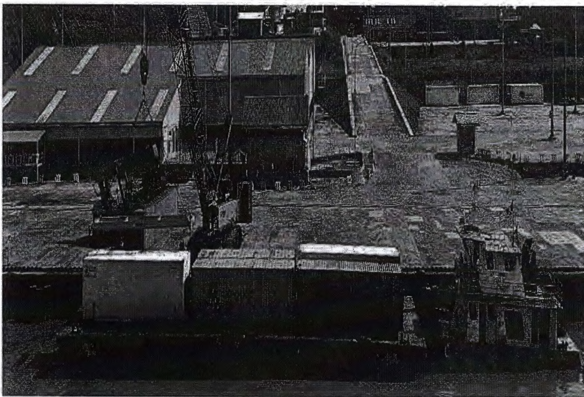
Foto 02: Nuevo Terminal Portuario Yurimaguas-Nueva Reforma
