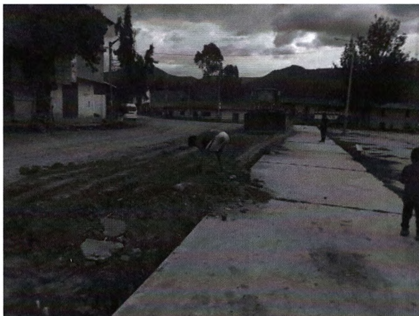
Trabajos de Reconstrucción de nuestra Plaza de Armas
