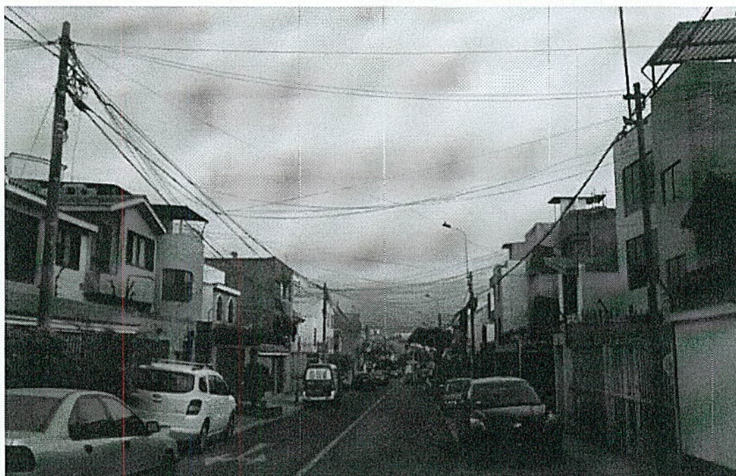
Cableados sin ordenamiento básico
