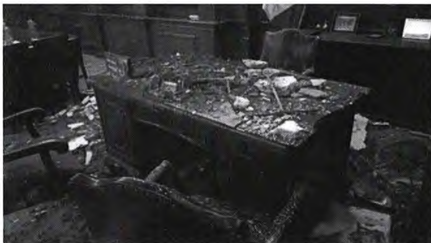
El escritorio de la congresista Juárez luego de que colapsara el techo de su despacho en marzo del 2023. Fuente: El Comercio 5 .
