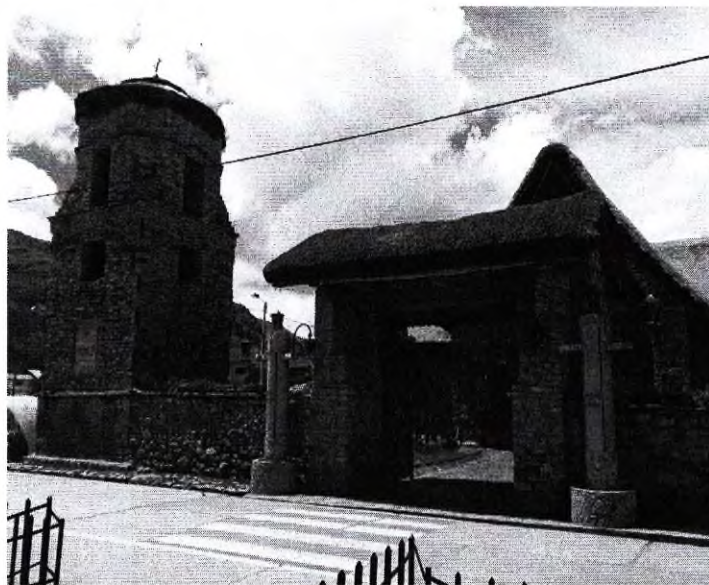
Fachada del ingreso de la Iglesia de San Pedro de Ninanca./ web
