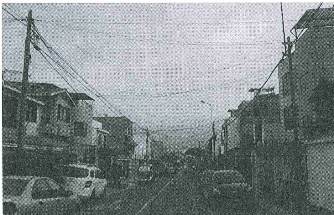
Cableados sin ordenamiento básico
