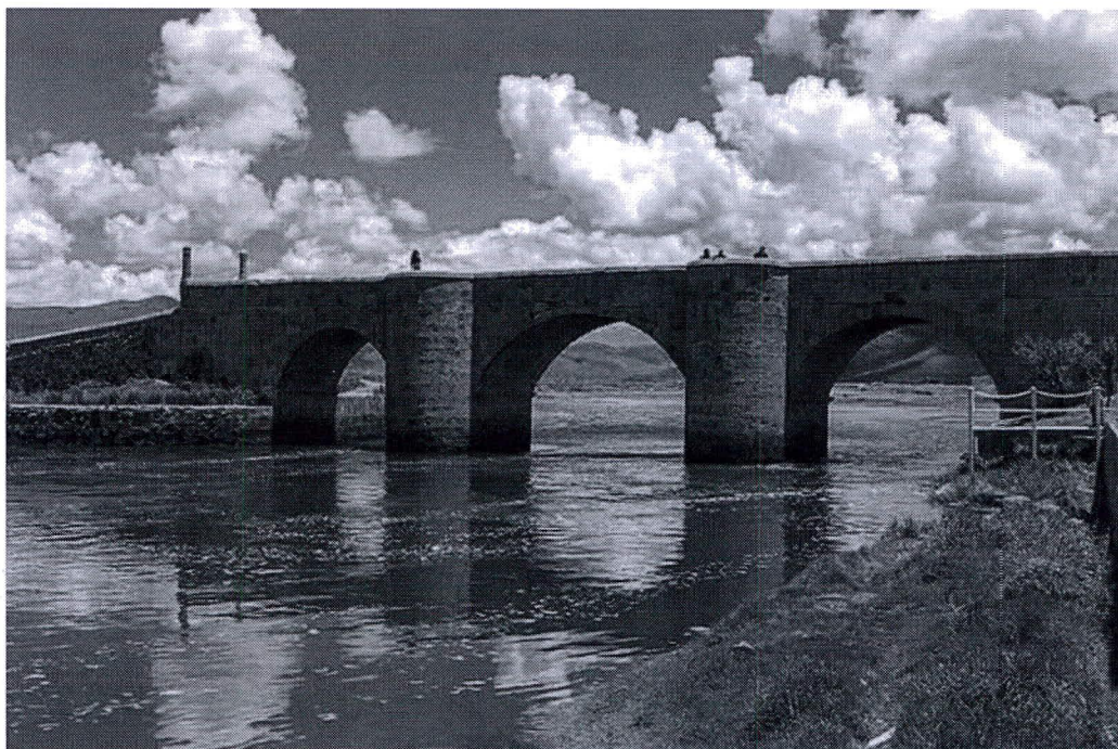
Fuente: Frase Corta, Puente colonial de Lampa-Puno.
