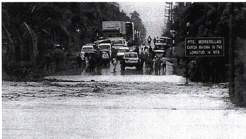
Quebrada que pasa por Morerilla se activa por las fuertes lluvias, bloqueando el pase vehicular.
