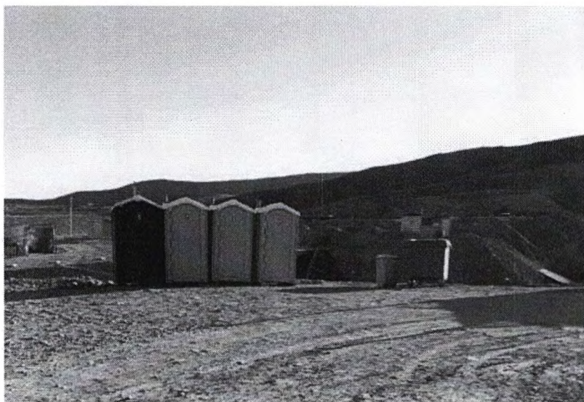
Baños químicos para el uso de la población.
