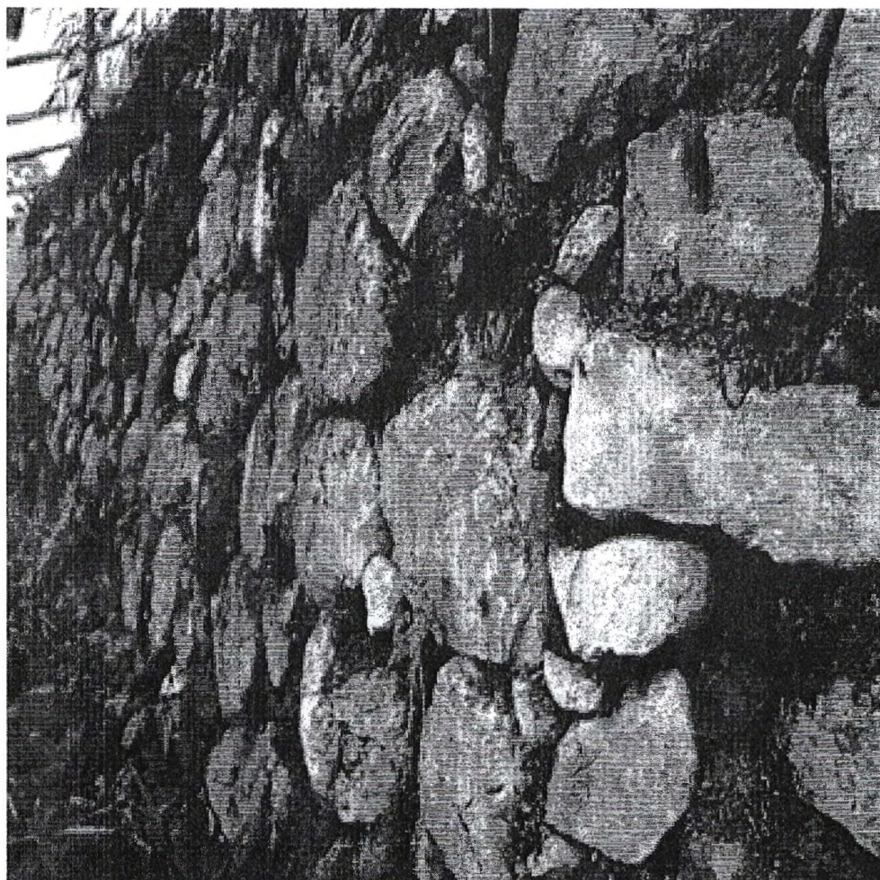
Detalle del muro este del edificio principal 8
