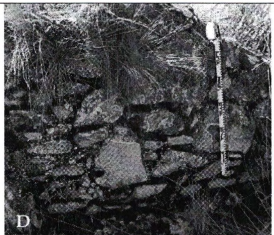
E Detalle de la técnica constructiva de los muros sobre la formación rocosa.
