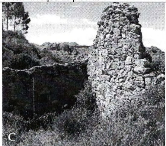
C Detalle del interior de la estructura mejor conservada del Sector Shamana 1.
