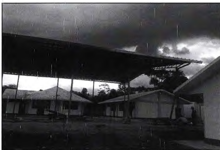
Figura 53: Construcción de Institución Educativa en el CP Vista Alegre
