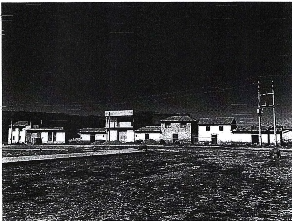
Foto: Sistema de energía eléctrica en el C. P. Ayrumas Carumas
