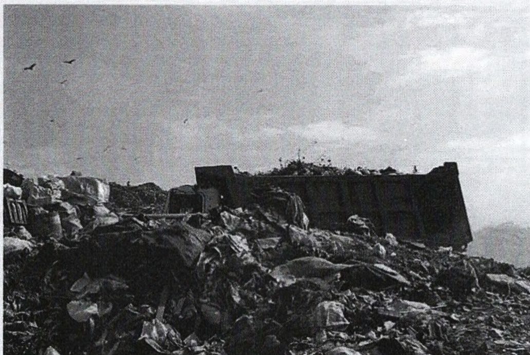
Relleno sanitaria es parte de la disposición final de los residuos sólidos y consiste en depositar en el suelo estos materiales, cubrirlos con una capa de tierra y compactar el materia. (Foto: Andina)
