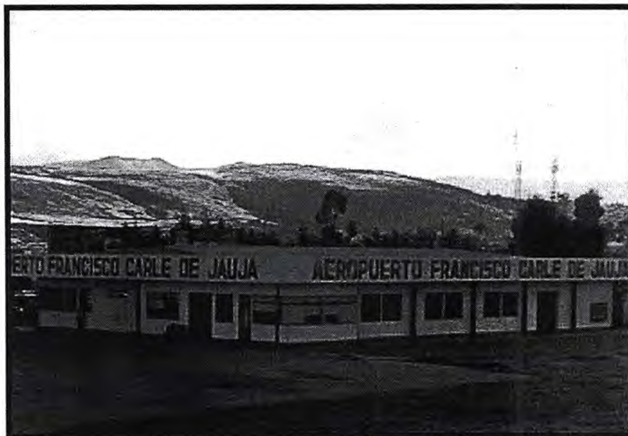
Pistas de Aterrizaje en pésimo estado y falta de mantenimiento y modernización de la infraestructura del aeropuerto Francisco Carle de Jauja
