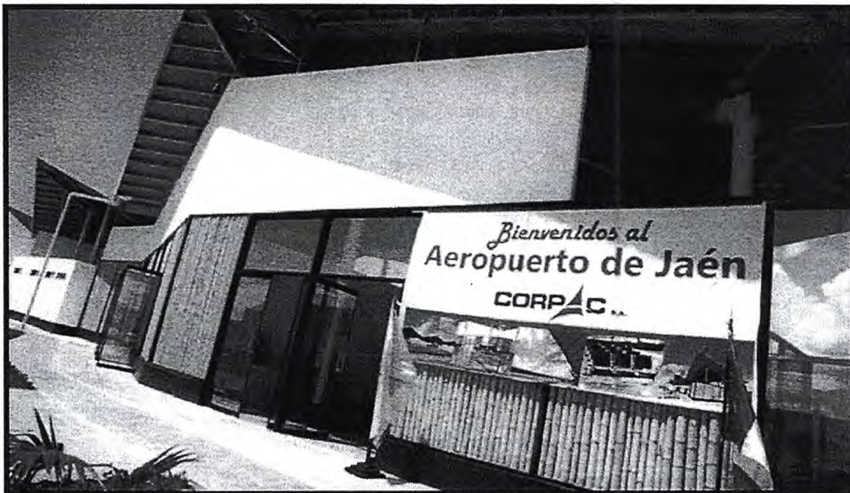
Falta de modernización de los espacios del aeropuerto Fernando Belaunde Terry
