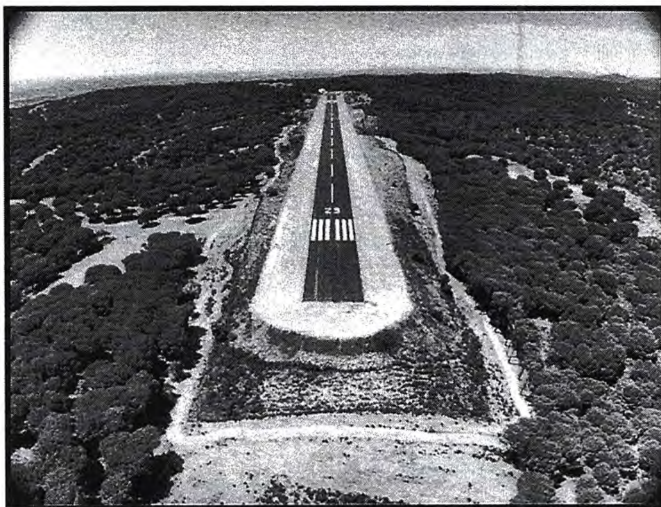
Pésima infraestructura de la pista de aterrizaje del aeropuerto de Jaén
