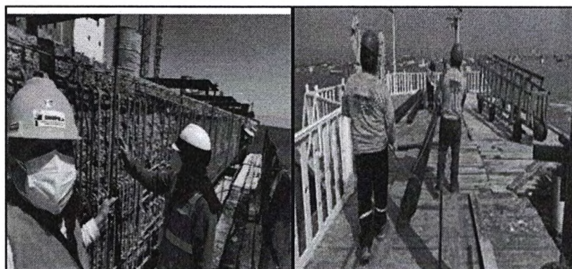
Reparación de pilotes de muelle terminal portuario ENAPU ILO
