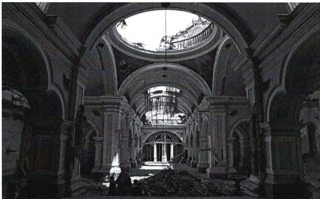
Catedral de Ica afectada luego del terremoto de 2007
