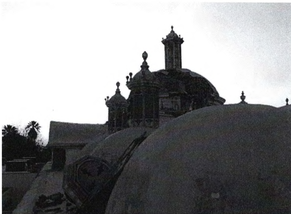
Vista externa de la Catedral de Ica donde se muestra los capulines sobre la nave del evangelio, al fondo la cúpula principal dañada en 2007
