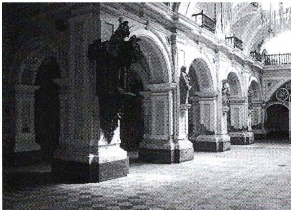
Vista interna de la Catedral de Ica donde se muestra los pilares entre la nave principal y las naves laterales
