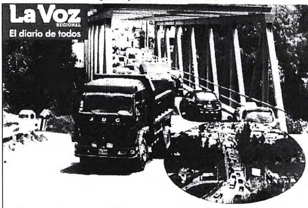
Fig. 6. Tráfico en el Puente la Breña.
