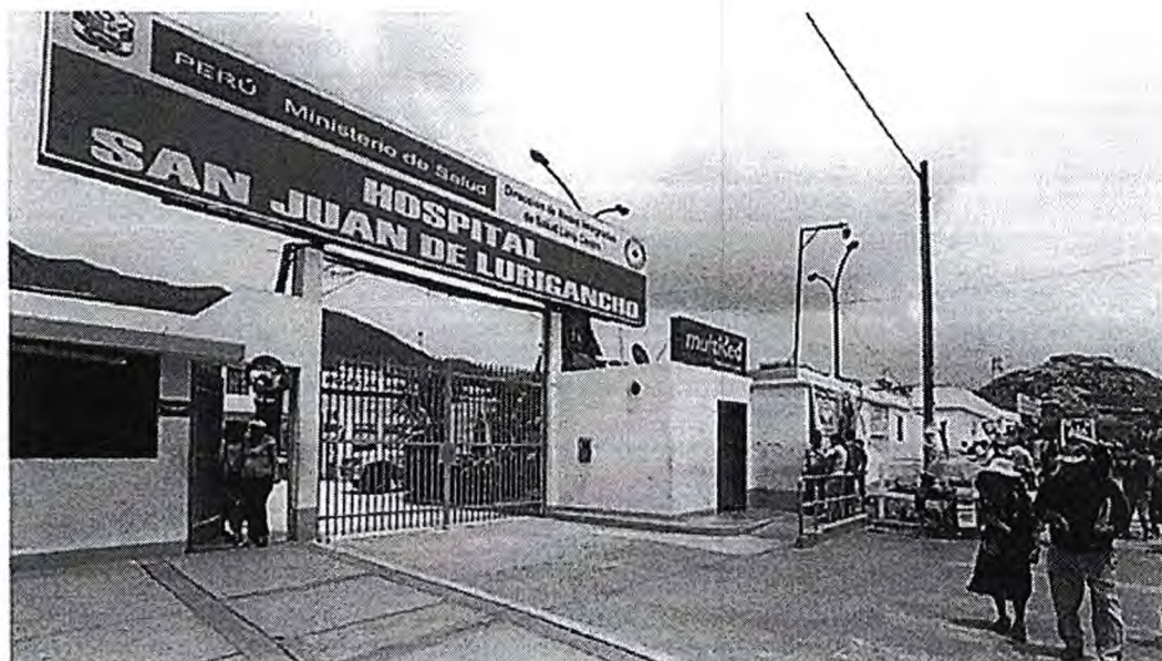
Hospital de San Juan de Lurigancho actual infraestructura
