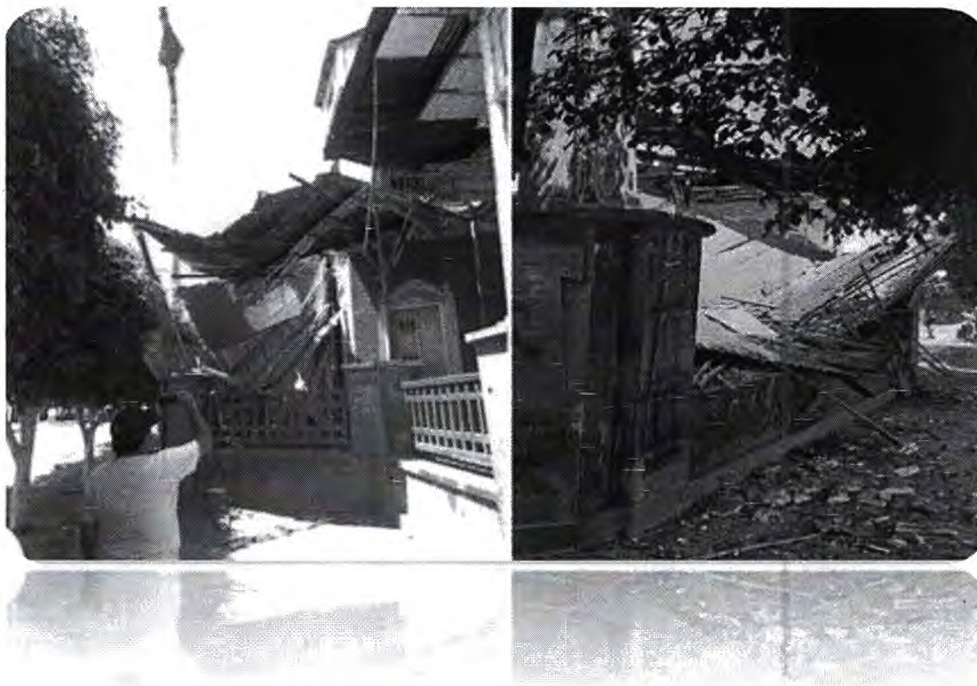
Figura No 9 Actualidad de la Casa Hacienda de Batán Grande
