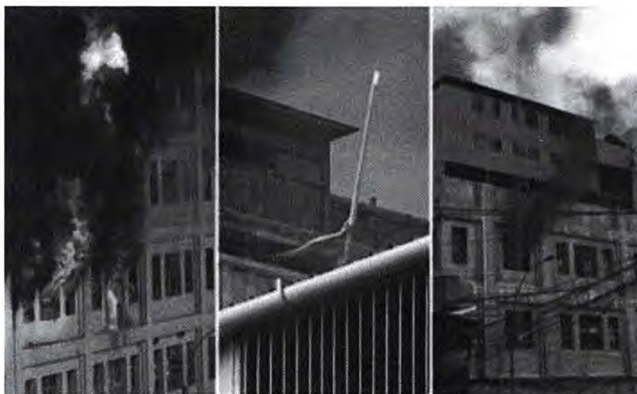
Imagen 1. Incendio en la galería Nicolini (Lima), donde murieron calcinados dos jóvenes que trabajaban en condiciones inhumanas
