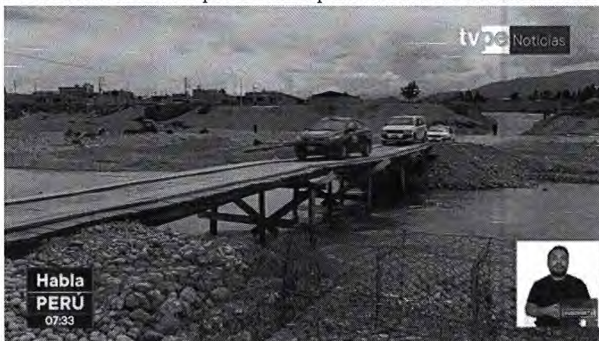
Figura 4: Puente construido por la Municipalidad Distrital de Huamancaca Chico
