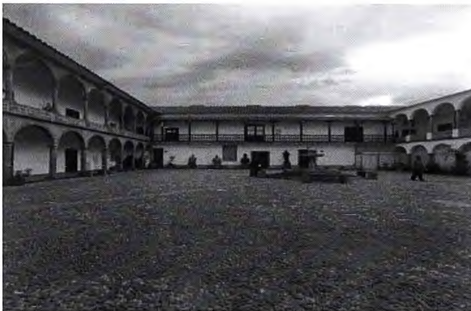
Fotografía 1: Patio central- Marques Cusco
