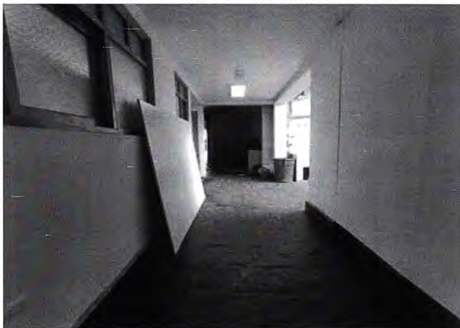
Fotografía 2: Pasillo de bloque II – Marques Cusco
