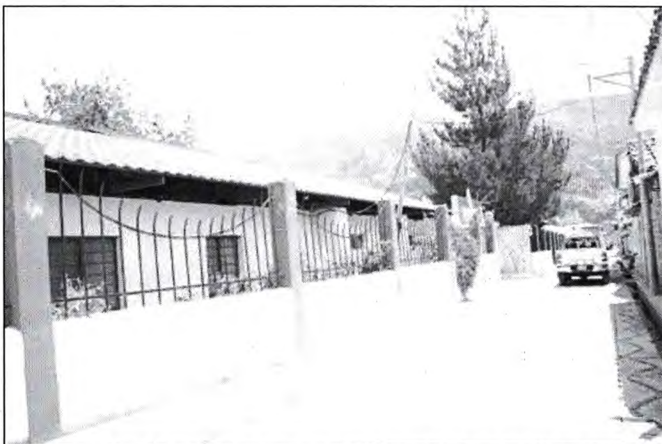
Fotografía 15: Avenida principal del local- CHECACUPE
