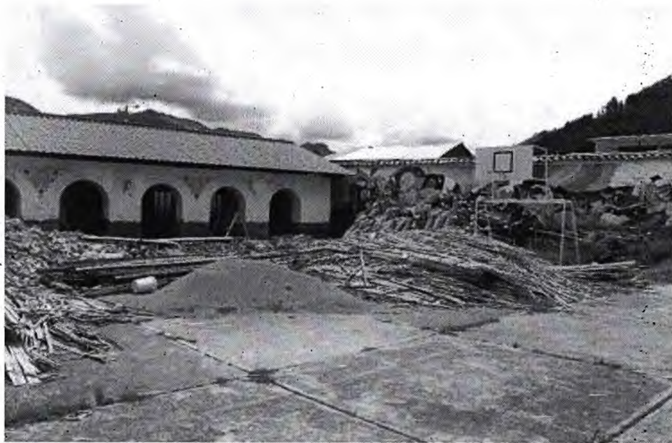
Fotografía 16: Patio central del local en fase de mantenimiento Aulas de humanidades– CHECACUPE
