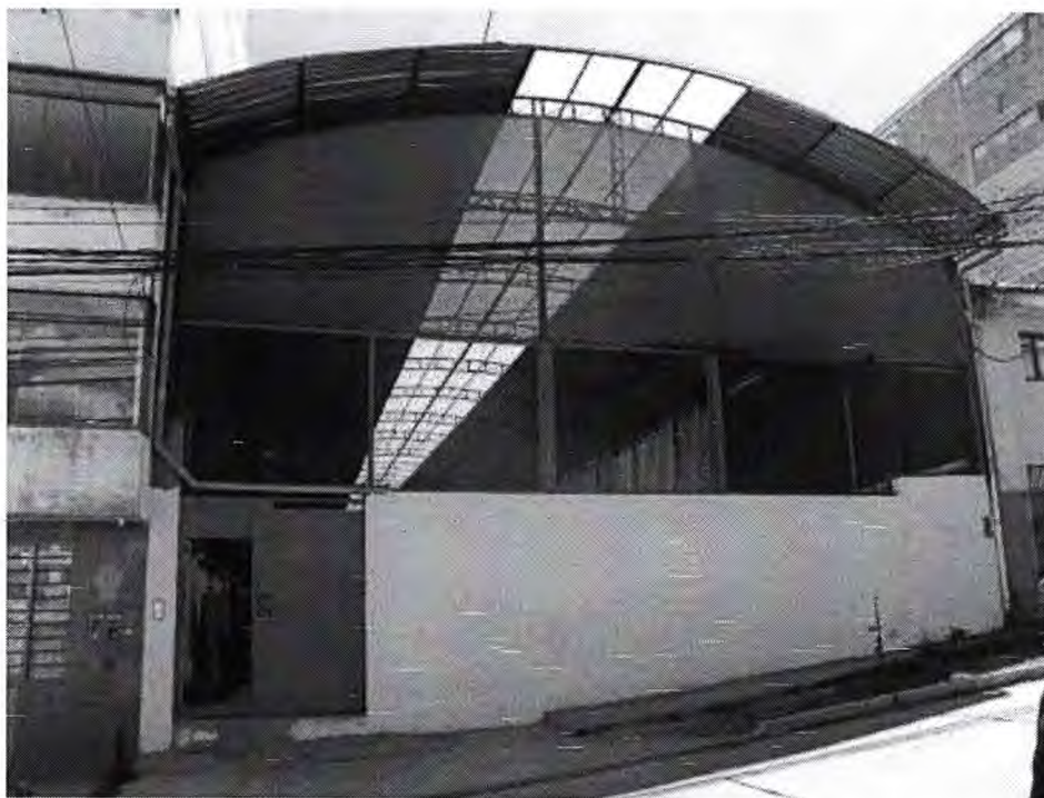
Fotografía 9: Vista exterior del local – Versalles II Cusco
