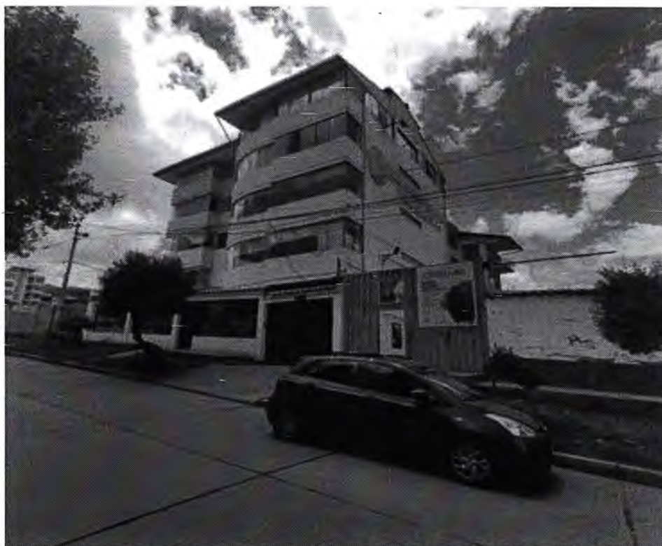
Fotografía 4: Vista exterior del local – Versailles I Cusco
