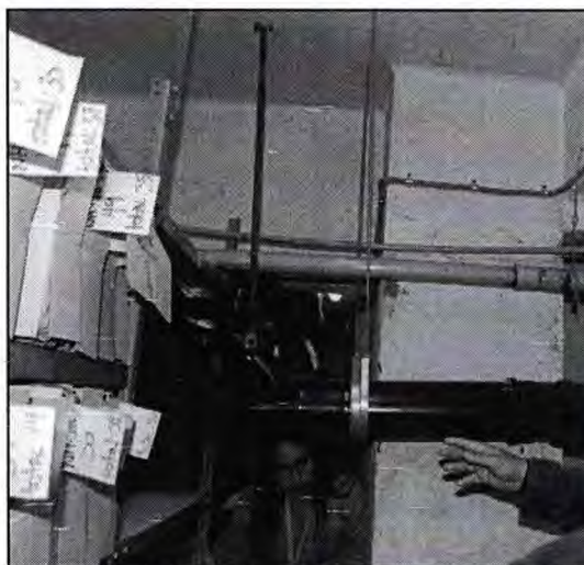
Imagen N° 8: Visita inspectiva a la sede del AGN en el Palacio de Justicia (2)
