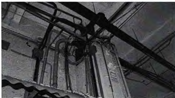
Imagen N° 11: Visita inspectiva a la sede del AGN en el Palacio de Justicia (5)
