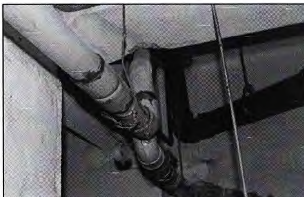
Imagen N° 7: Visita inspectiva a la sede del AGN en el Palacio de Justicia (1)
