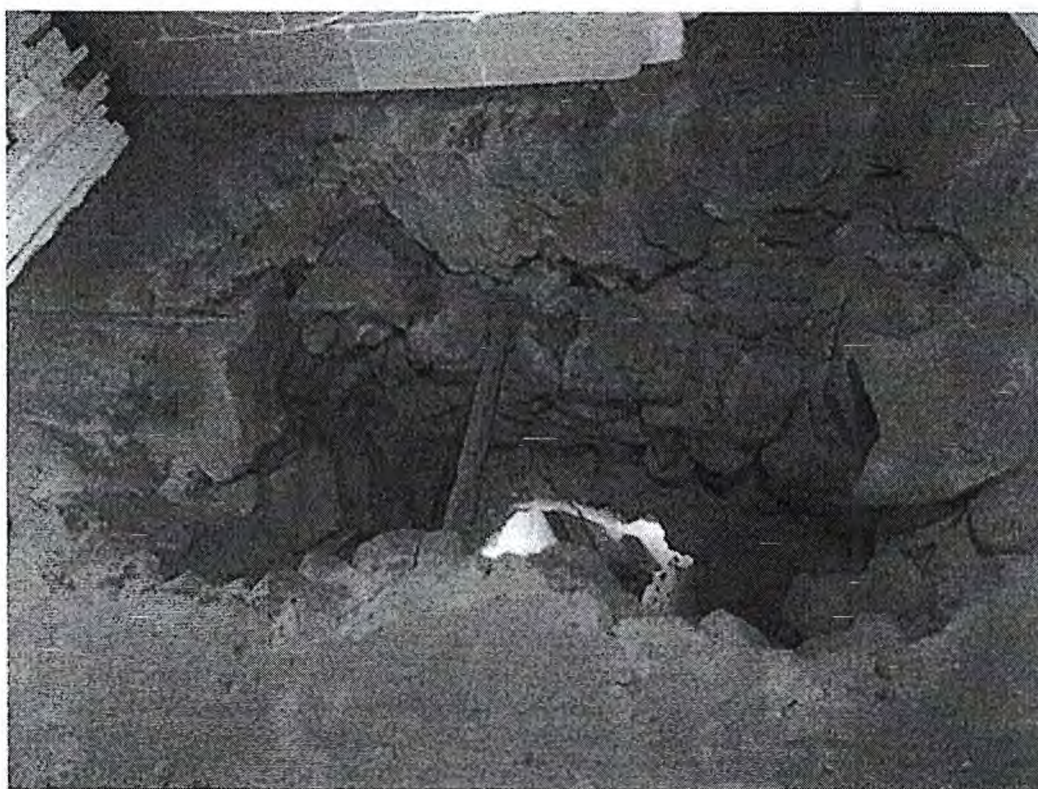
6.- Forado en el entrepiso de la torre izquierda, que pone en peligro su estabilidad
