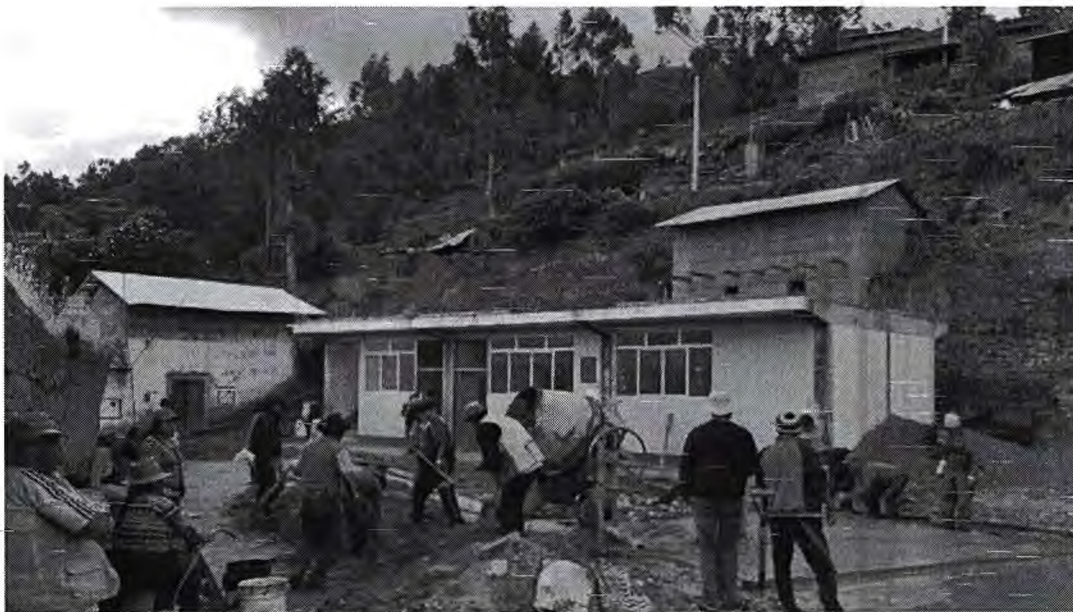
Figura 4: Centro Poblado de Bella Vista construyendo su plaza con sus propios recursos
