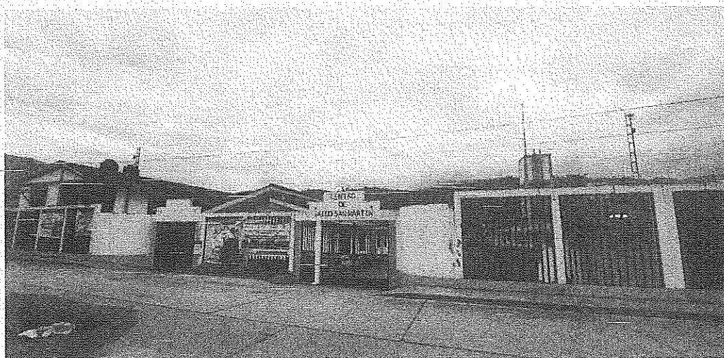
IMAGEN N° 002 : VISTA DEL FRONTIS DEL CENTRO DE SALUD SAN MARTÍN
