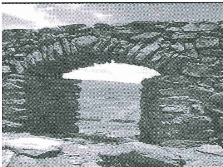
Puerta de la capilla tomada desde el interior Fuente: Pilco (2020)
