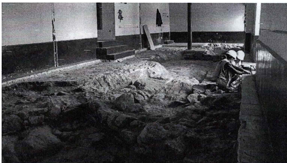
Imagen 2 Muros de piedra
