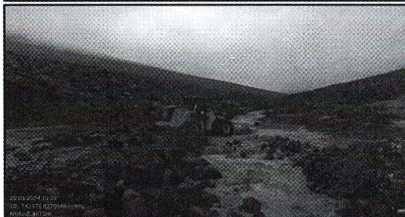
Situación de la vía Chuquibamba-Cotahuasi en época de lluvias
