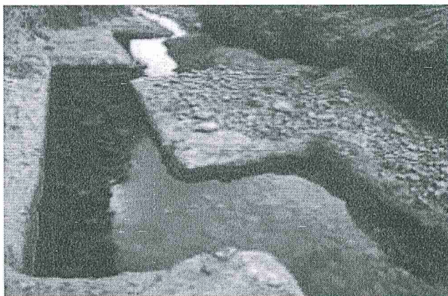
Parte del Canal de Cumbemayo
