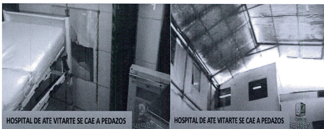
Infraestructura interna del Hospital Vitarate 15 .
