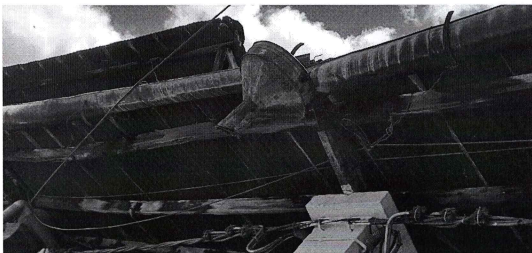
Parte externa del techo e instalaciones eléctricas.
