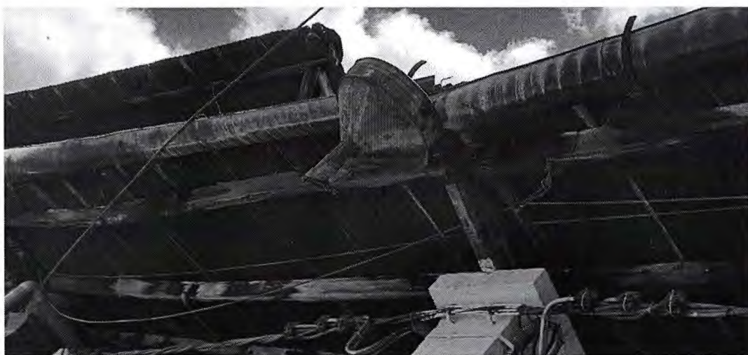
Parte externa del techo e instalaciones eléctricas.
