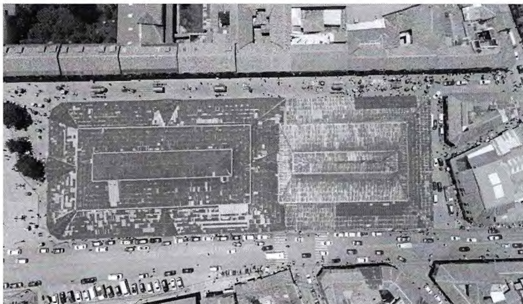
Vista panorámica del techo del Mercado Central de San Pedro
