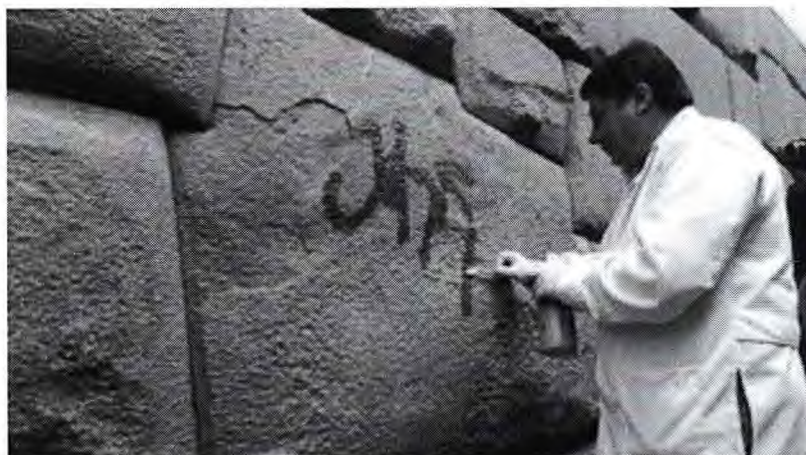
Grafico 01: Daños en la Piedra 12 Ángulos
