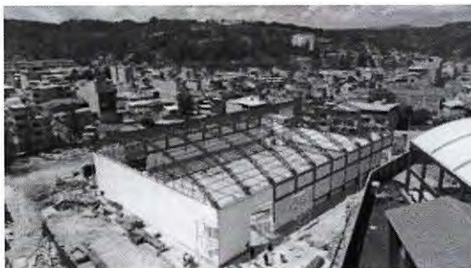
Figura 5 - Vista área instalaciones del IESP Octavio Matta Contreras
