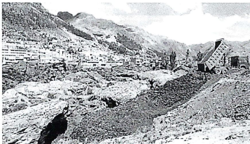
Desmonte pone en riesgo a Paturpampa
