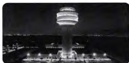
Nueva torre de control no operativa debido a falta de cambio de vidrios (18 de Octubre)
