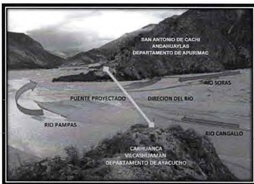
Proyectado del puente VIRAN - 450 metros, conectividad entre las provincias de Vilcas Huamán y Andahuaylas.
