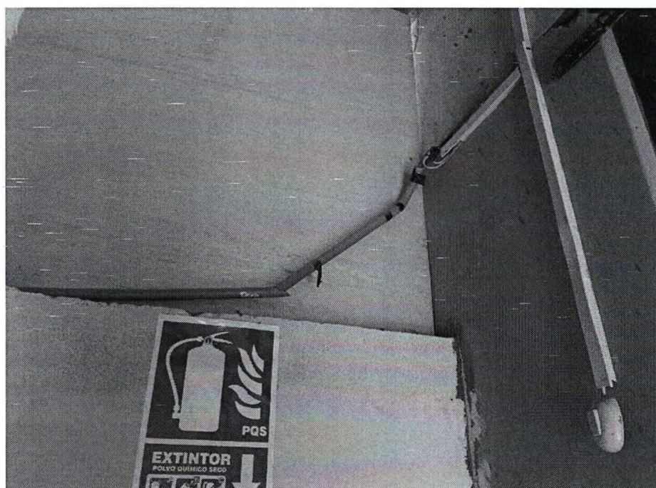
Fotografía 4. Conexiones eléctricas deficientes que con la filtración de luvias puede provocar serios daños humanos.
