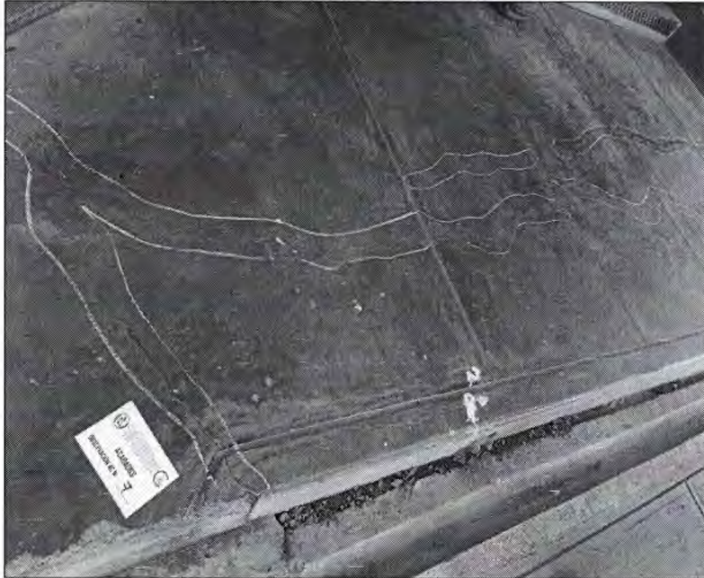
Fotografía 2. Rajaduras leves de 1cm en paredes.
