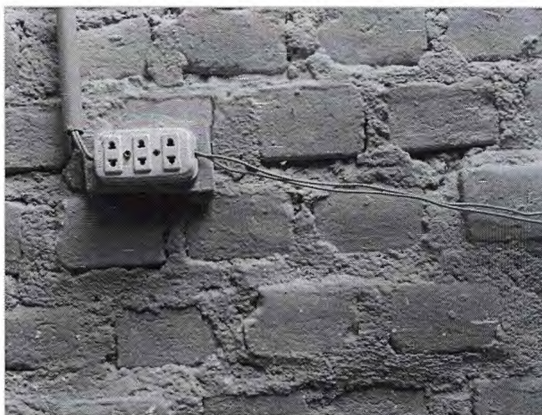
Fotografía 8. Conexiones eléctricas deficientes que con la filtración de lluvias puede provocar serios daños humanos.
