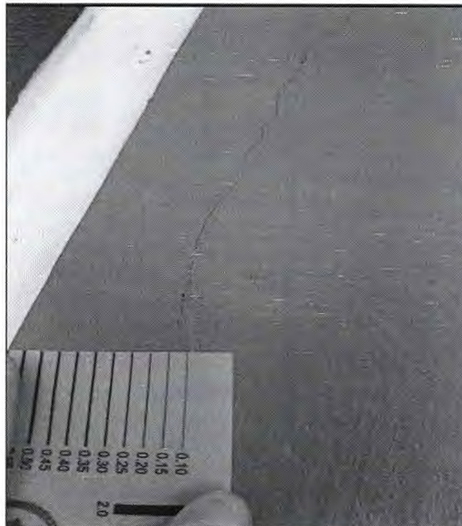
Fotografía 2. Rajaduras leves de 1cm en paredes.
