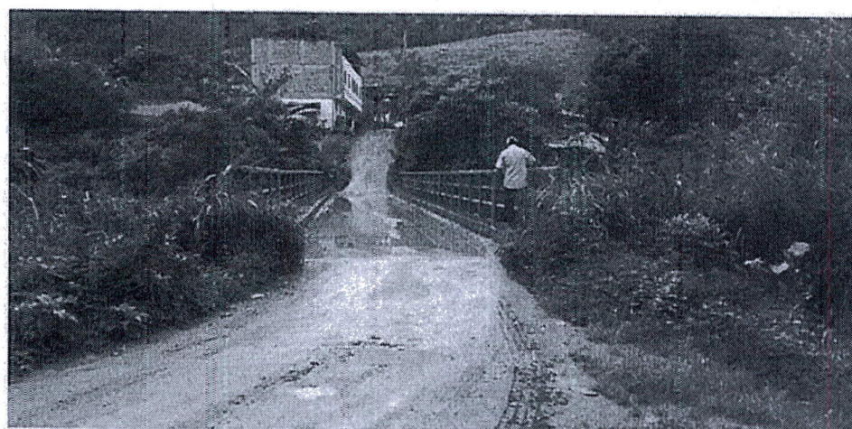
Imagen N° 08: PUENTE CARROZABLE DEL CASERÍO PUERTO SAN FRANCISCO- CONSTRUIDO SOBRE EL CAUSE DEL RIO TABACONAS
