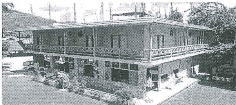
Figura 108. Construcción con bambú.
