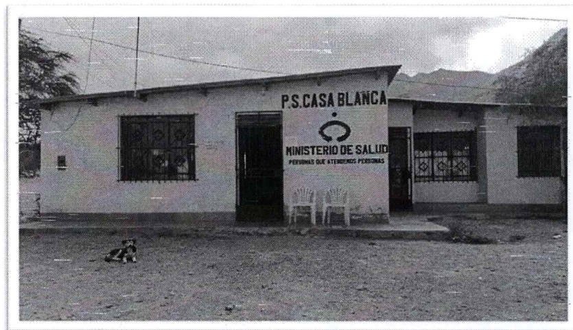
Imagen N°4 Fotografía del Puesto de Salud de Casa Blanca.
