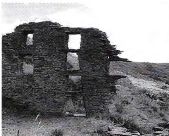
Construcción cinco ventanas
