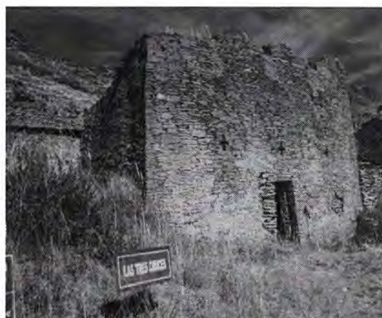
Construcción las tres cruces
