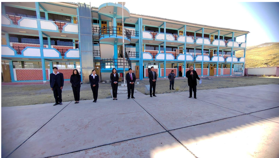
IMAGEN 05. Infraestructura académica del IESTP - Santa Lucía
